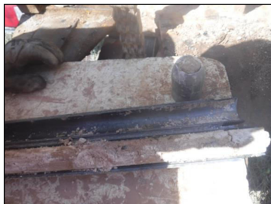
Foto 20: Sondeig S-8, SPT a 2,6 metres.
