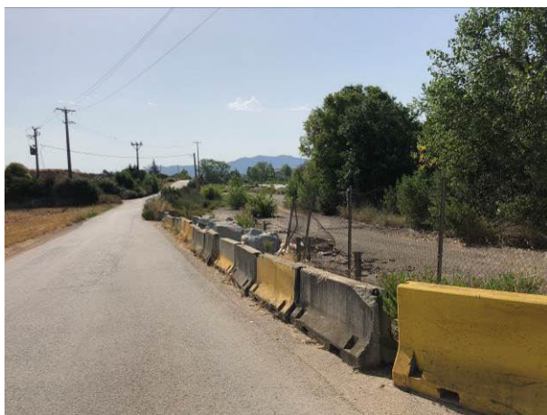
Foto 1: Serveis aeris. Primer tram carrer Del Camí de Parets.
