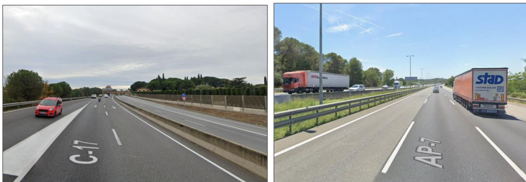
Figura 28. Carretera C-17 i AP-7
