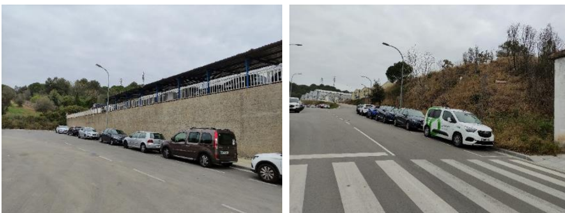
Mur de contenció (extrem nord-oest de l'àmbit) i talús (extrem sud-oest) en la trobada amb el c/ Josep Trueta. Font: elaboració pròpia.
