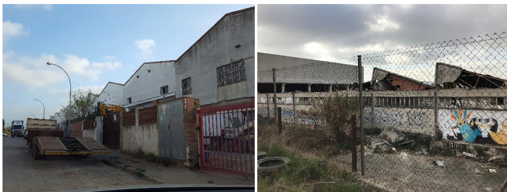
Imatges d'instal·lacions industrials. La imatge de la dreta correspon a una nau en desús i en runes
